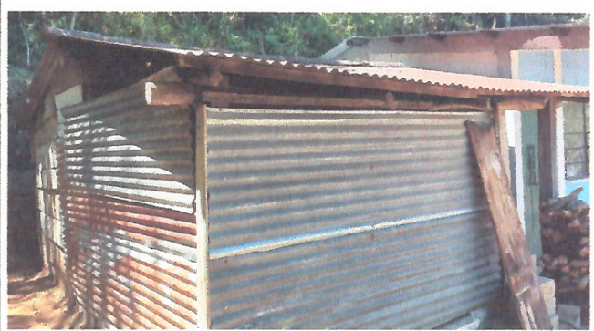
Foto 2: Reparación y mejoramiento general de cocina.
