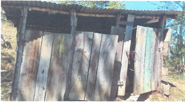
Foto 1: Mejoramiento general de sanitario y fosa séptica
