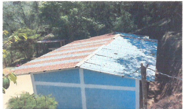
Foto 4: Mejoramiento y estructura de techado.
