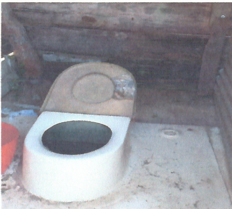
Foto 3: Mejoramiento general de sanitario y fosa séptica
